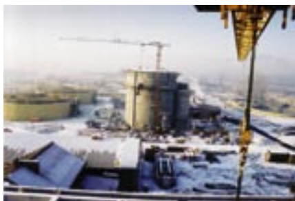
Fot. 3. Widok ukończonego zbiornika na ścieki
