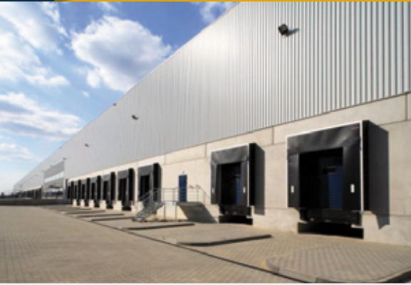
Panattoni Park Kraków o docelowej powierzchni 17 tys. m 2 , zdj. Cushman & Wakefield
